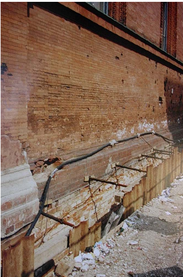
Spundwände in unmittelbarer Nähe der Wand.
